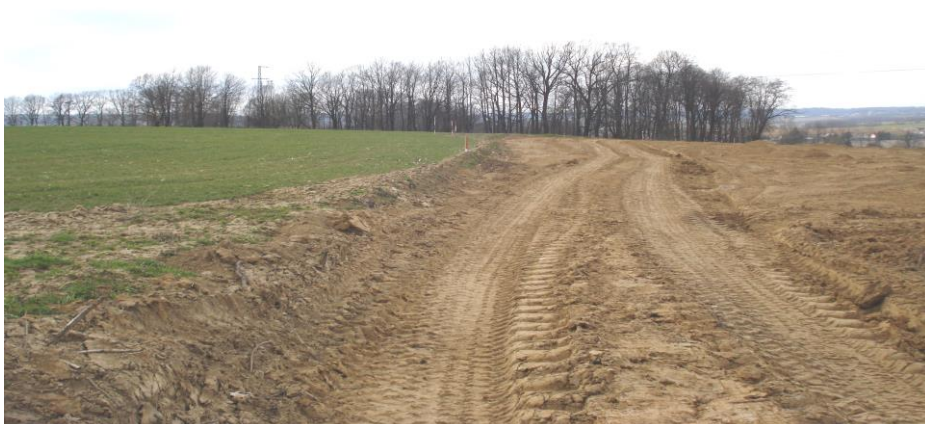
Hladké Životice 1 – pohled na lokalitu od východu před výstavbou nové komunikace a mostu.
