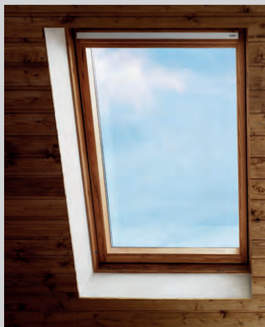
Výměna starého střešního okna za nové
