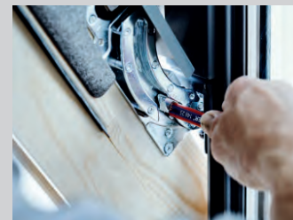
Promazání nebo výměnu okenních závěsů
