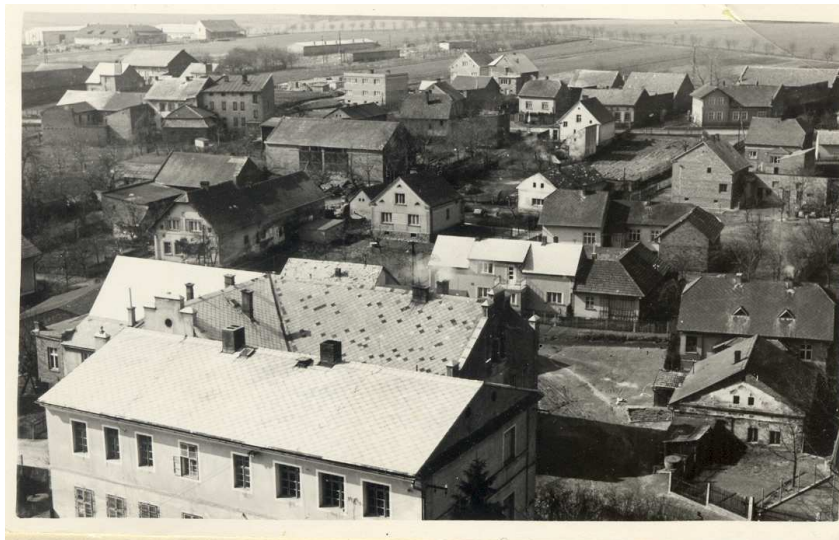
Pohled na obec od staré školy na západ. V pozadí drůbežárna, kravíny JZD. Snímek z r. 1917.
